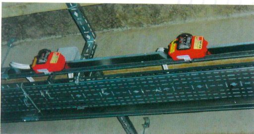
Kablolama alt yapısının yenilenmesi
